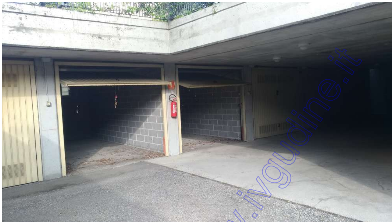
a sinistra autorimessa sub 16
